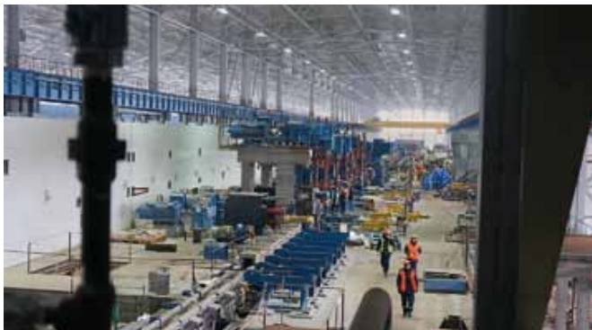
Монтаж крупногабаритного промышленного производственного оборудования к бетонным фундаментам при проведении реконструкции (сквозной монтаж после расстановки конструкций в проектное положение)
