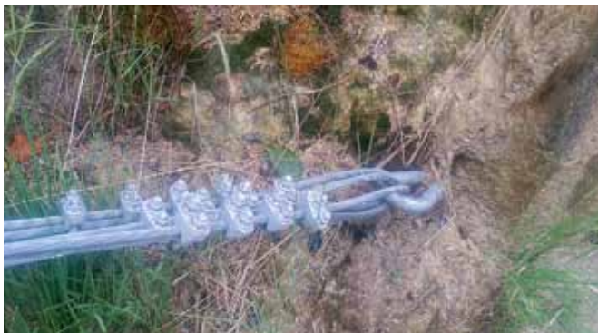
Узел крепления оттяжки кольчужной сетки динамического противокаменного ограждения энергоемкостью 500 кДж непосредственно в горную породу (глубина заделки анкера 1500 мм)
