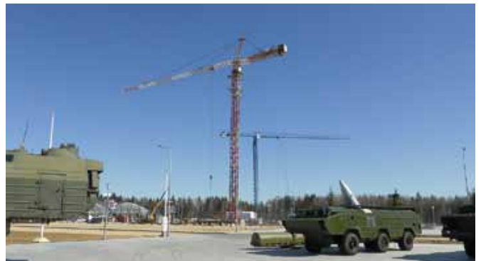
Монтаж башенных кранов и металлоконструкций к железобетонным фундаментам на объектах специального назначения (Российская Федерация, 2016 г.)
