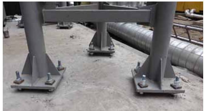
Закрепление опор труб газовой котельной: резьбовая шпилька M24, глубина заделки L = 1200 мм (Центр дизайна «ARTPLAY», г. Москва, 2016 г.)
