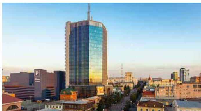
Усиление фундаментов и плит перекрытий крытого паркинга (деловой центр «Челябинск-Сити», г. Челябинск, 2017 г.)
